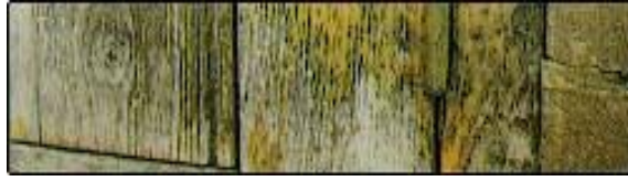
Resim 1.10: Ahşap yüzeylerde portakallanma
