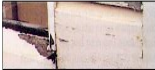
Resim 1.15: Ahşap yüzeylerde görülen kabarma
