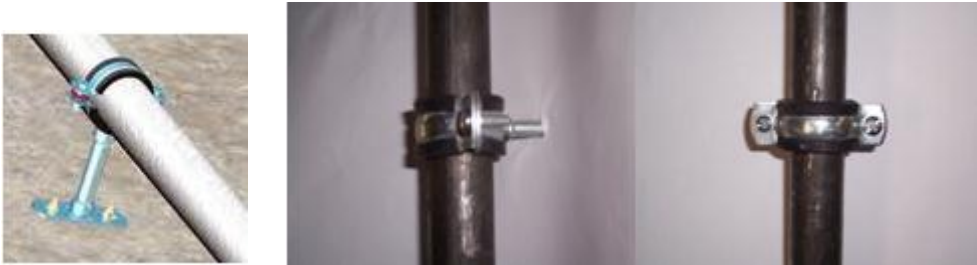
Resim 2.1: Borulara yatay ve dikey konumda kelepçe montajı
