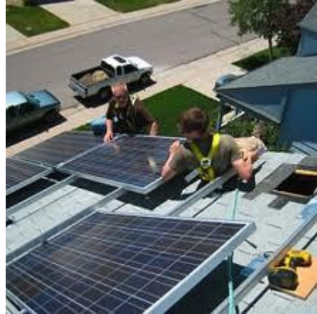
Resim 2.2: Metal raylar ve güneş panelleri
