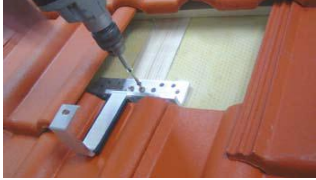
Resim 2.5: Kirişlerin üzerine çatı köşebendi montajı
