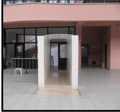
Resim 1.2: Havuza giriş öncesi duş ve ayak yıkama bölümü
