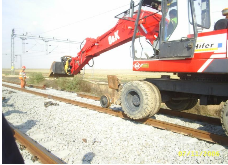
Resim 1.4: Makine ile ray çekimi
