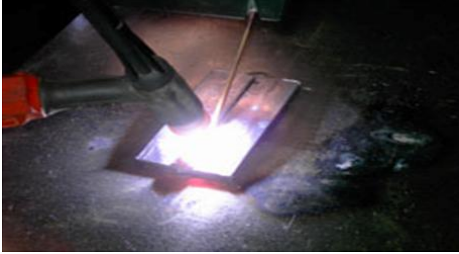
Şekil 4.1: TİG kaynak metodu ile bakır kaynağı
