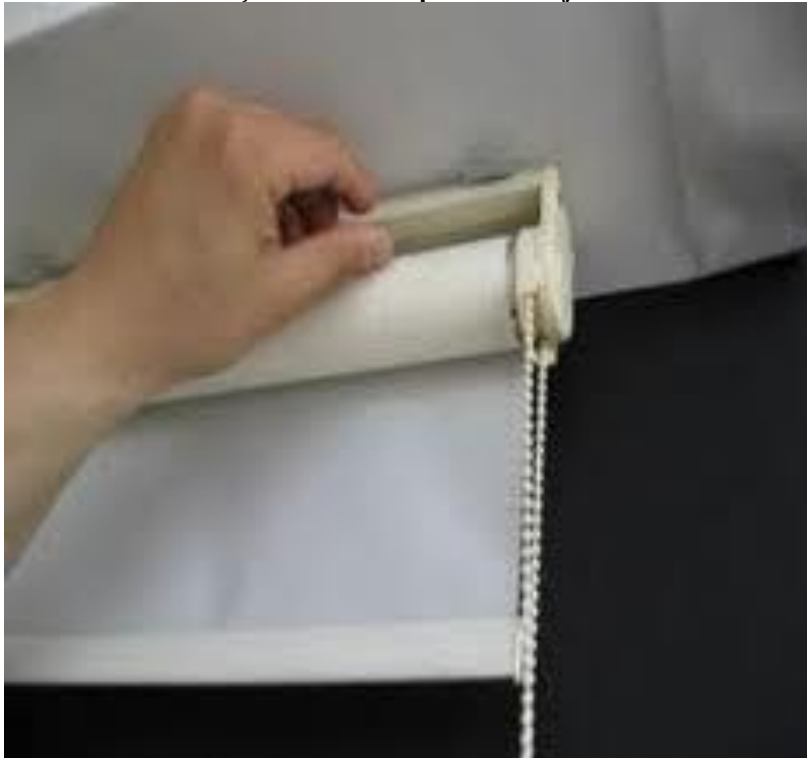
Şekil 1.14 : Stor perde montajı
