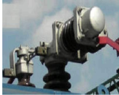
Şekil 2.2: Basınçlı hava ark söndürme hücreli kesici
