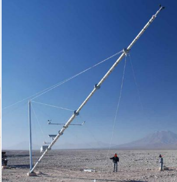
Resim 2.2: Boru tipi ölçüm direği
