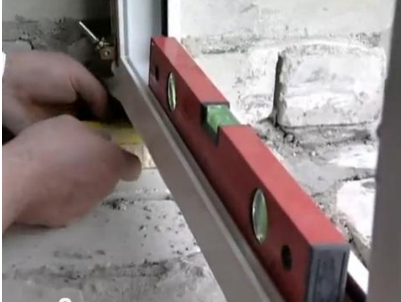
Resim 3. 1: Taşıma takozları yardımıyla doğramanın şakuline getirilmesi
