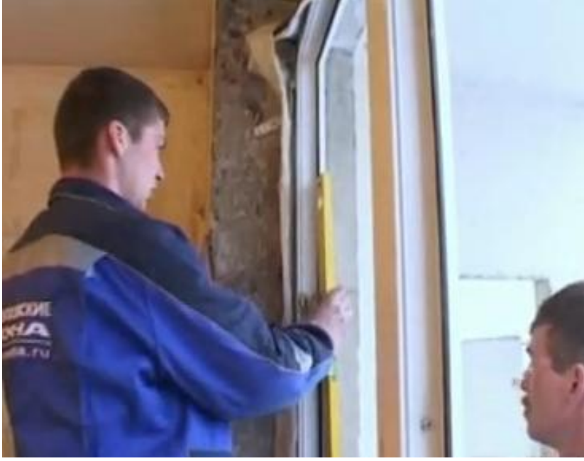
Resim 4. 2: Kapının dikey şakülüne bakılması
