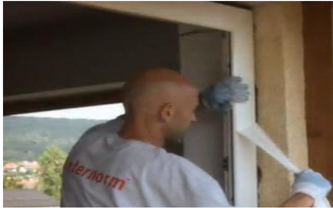
Resim 3. 11: Koruma bantlarının sökülmesi
