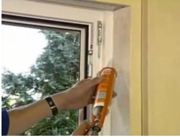
Resim 3. 8: Silikon mastik çekilmesi
