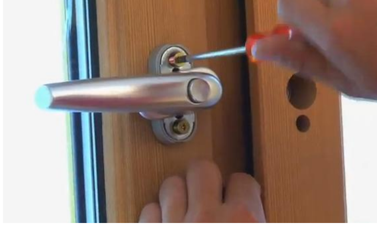
Resim 3. 10: Pencere kolunun takılması
