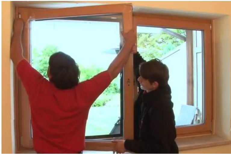
Resim 3. 9: Kanatların takılması
