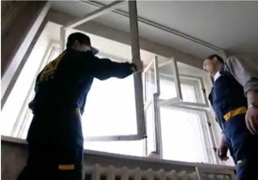
Resim 1. 1: Kanatların çıkarılması
