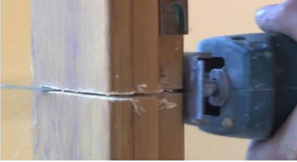
Resim 1. 2: Orta kaydın testere ile kesilmesi
