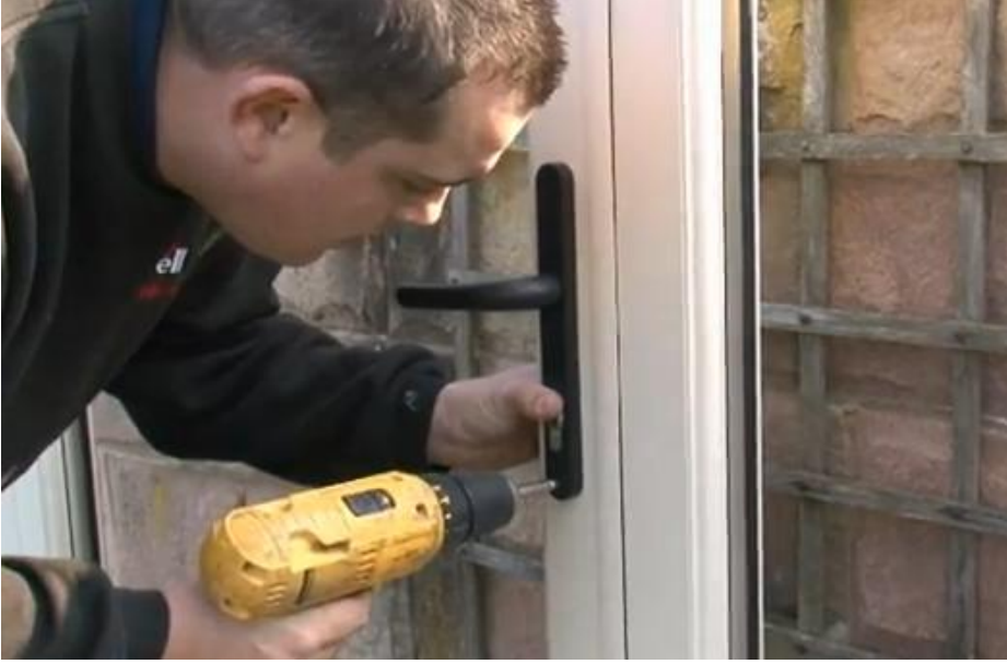
Resim 4. 5: Kapı kolunun takılması
