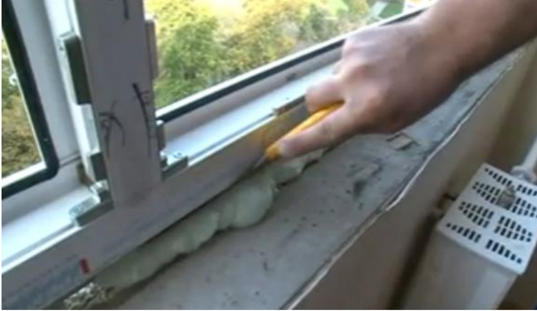
Resim 3. 5: Falçata vb. keskin alet yardımıyla köpüklerin taşan kısımların kesilmesi
