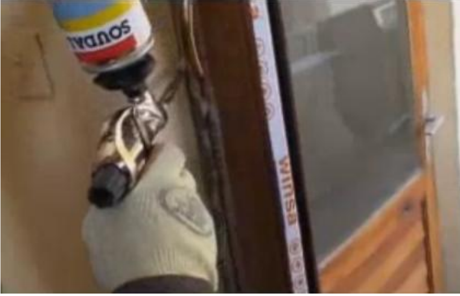
Resim 4. 4: Kasa kenarındaki boşlukların doldurulması
