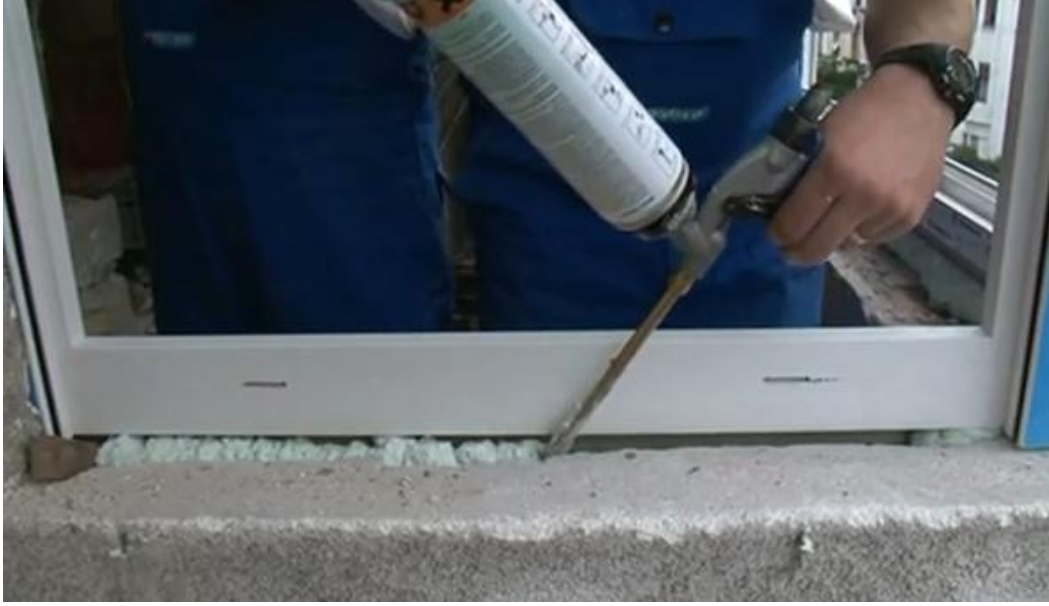
Resim 3. 4: PVC doğrama ile duvar arasının köpikle doldurulması
