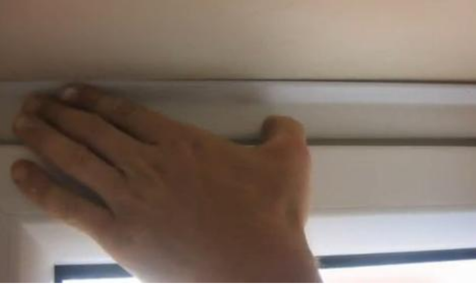
Resim 3. 7: Pervazın yapıştırılması
