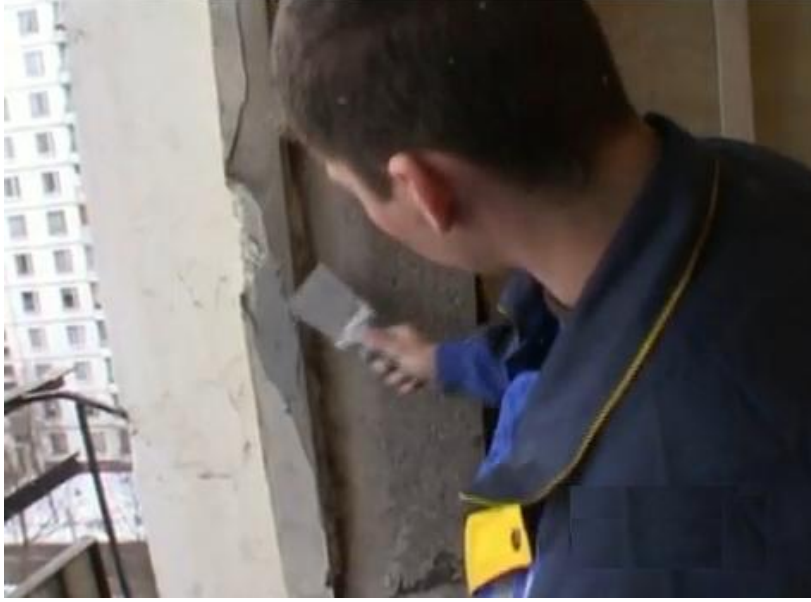
Resim 1. 4: Sıva tamirati yapılması:
