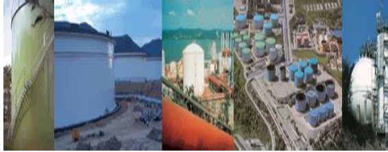
Resim 2.1: Boya ile korozyondan korunan tanklar
