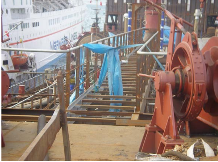
Resim 1.2: Kedi köprüsü yapımı ve montajı
