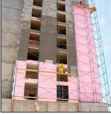
Resim1.9: Binalarda mantolama ve çatı ızalasyonu
