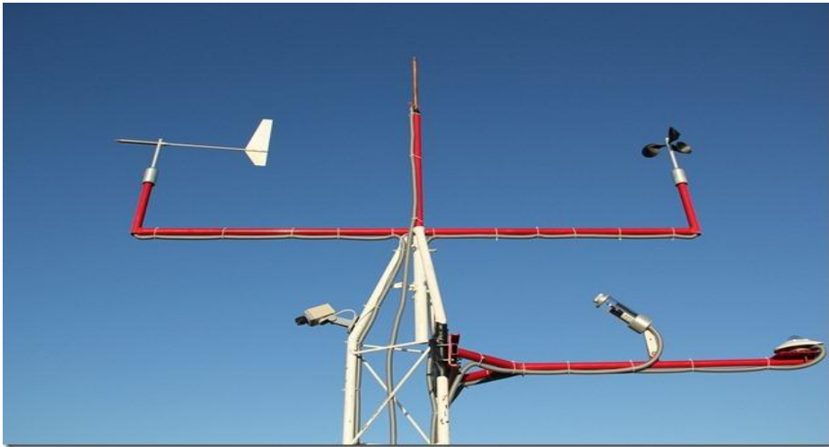
Resim 2.1: Ölçüm elemanlarına ait kabloların direğe sabitlenmesi
