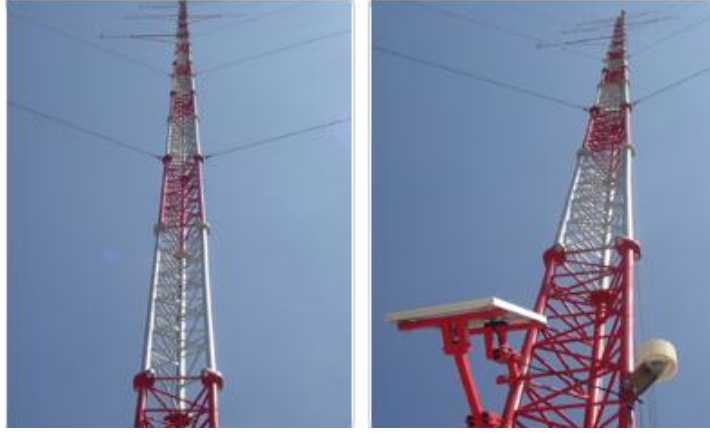
Resim 1.3: Kafes tipi ölçüm istasyonu direği
