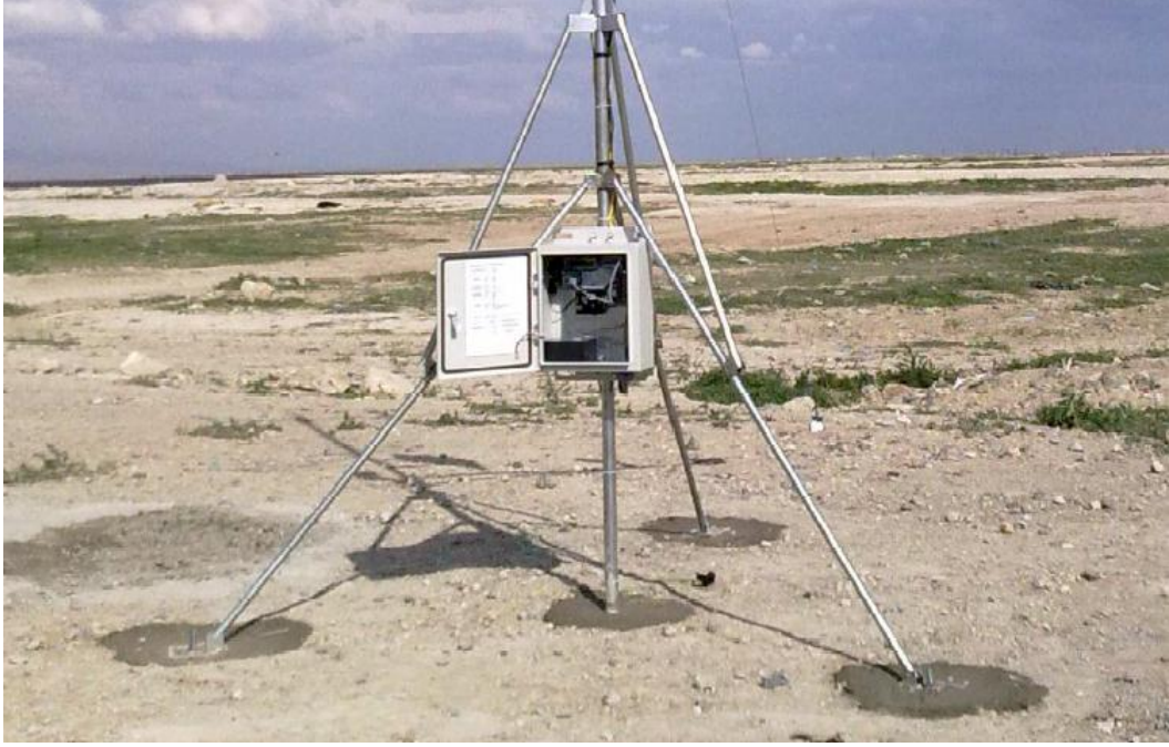
Resim 1.1: Güneş ölçüm direğinin temel çukurlarına yapılmış montajı
