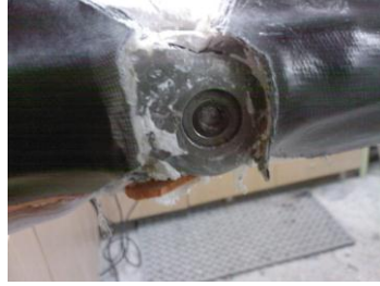
Resim 2.4: İzole edilen eklem yerlerinin temizlenmesi
