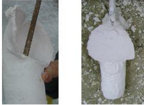
Resim 2.9: Baėlantı ubuėunun yerleřtirilmesi
