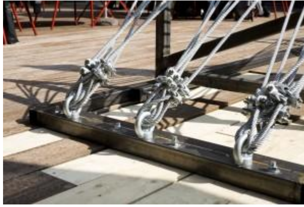
Resim 2.2: Gerdirme bağlantısı
