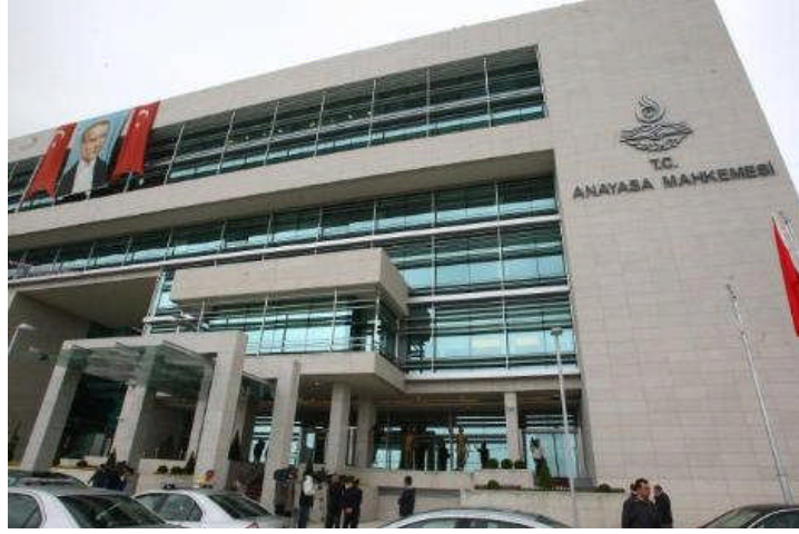
Fotoğraf 2.1: Anayasa Mahkemesi binası
