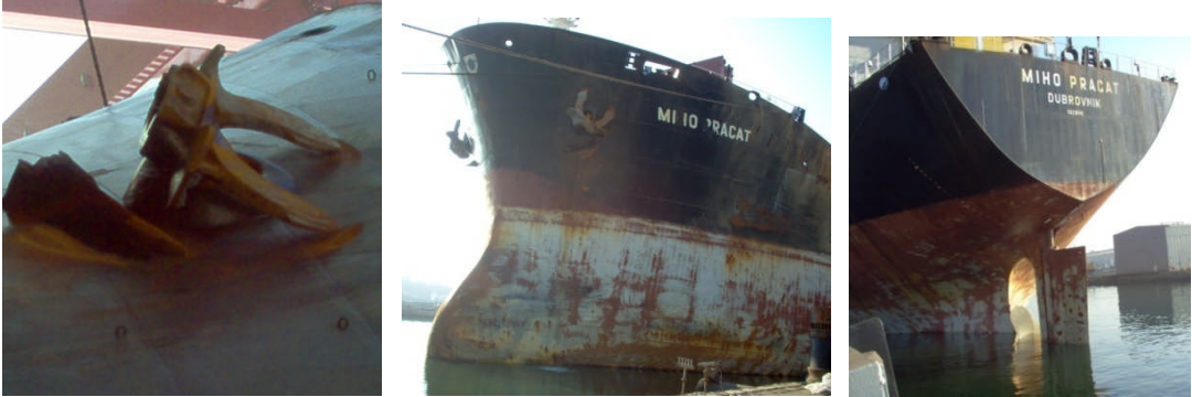
Resim 2.3: Gemi sacının korozyonu
