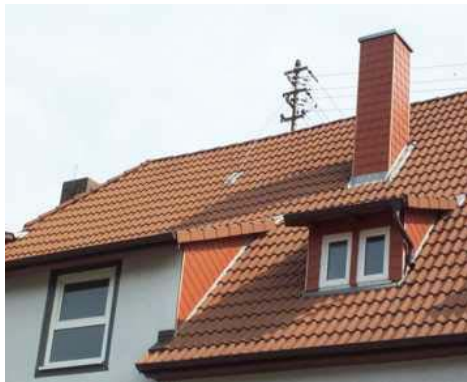
Resim 1.1: Çatı kaplaması ile baca arasında ara kesitin oluşması
