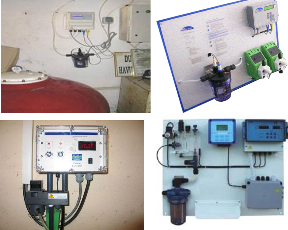
Resim 2.4: Otomatik serbest klor ölçüm cihazları
