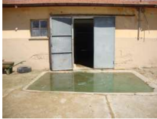
Resim 2.4: İşletme girişine yapılan ayak havuzu
