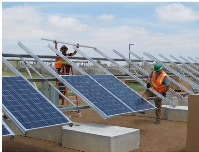
Resim 3.2: Güneş sehpa montajı
