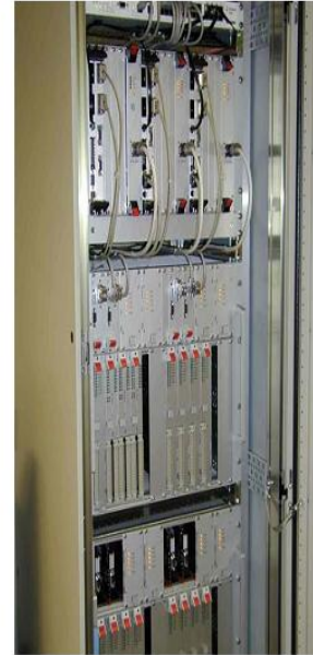
Şekil 3.1: Elektronik interlocking sisteminin cihazı ve blok diyagramı
