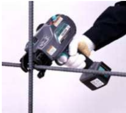
Resim 3.3: Donatıyı Makine ile baęlama
