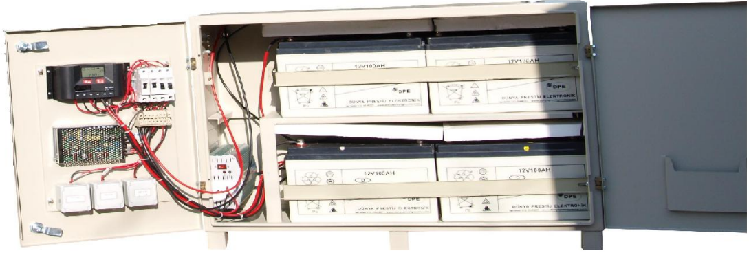
Resim 2.9: Güneş panel sistemi güç kumanda panosu
