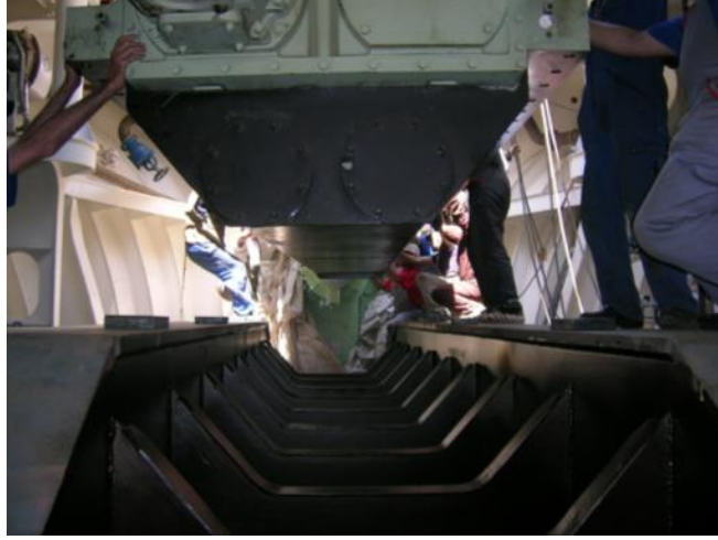
Resim 1.1: Ana makinenin fandeyşına yerleştirilmesi
